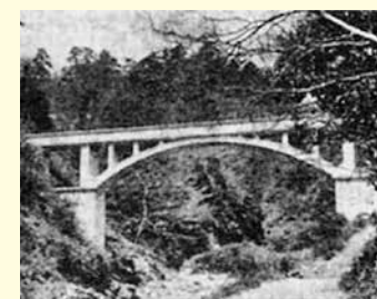
建設当時の水管橋
